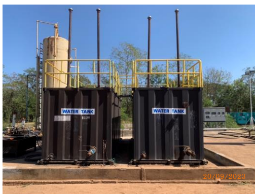
รูปที่ 2-22 ถังเหล็กสำหรับกักเก็บน้ำจากกระบวนการผลิตขนาด 200 บาร์เรล
