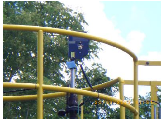
รูปที่ 2-39 การติดตั้งอุปกรณ์วัดระดับที่ถังเก็บน้ำมันดิบ
