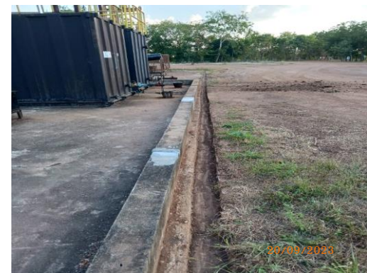
รูปที่ 2-41 รางระบายน้ำรอบพื้นที่คอนกรีต
