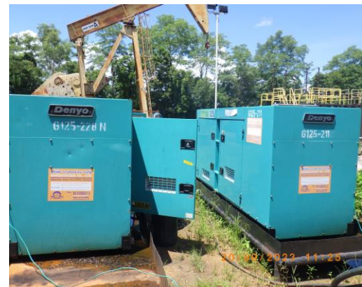
รูปที่ 2-15 การจัดวางเครื่องกำเนิดไฟฟ้าพร้อมภาชนะรองรับ เพื่อป้องกันการปนเปื้อนของน้ำมัน
