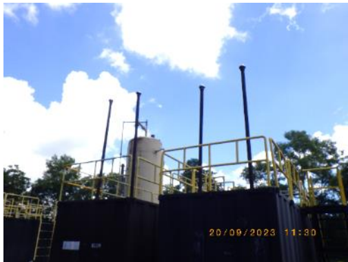
รูปที่ 2-38 การติดตั้งท่อระบายอากาศ บริเวณด้านบนของถังเก็บน้ำมันดิบ
