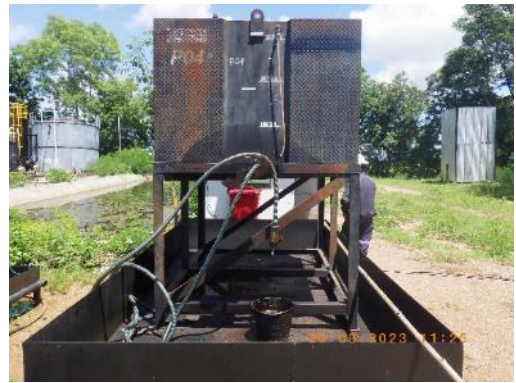
รูปที่ 2-10 ถังเก็บน้ำมันเชื้อเพลิงแบบเคลื่อนย้ายได้ พร้อมภาชนะรองรับ
