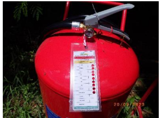
รูปที่ 2-37 การตรวจสอบอุปกรณ์ดับเพลิง
