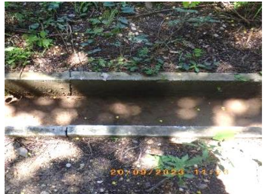
รูปที่ 2-8 รางระบายน้ำโดยรอบพื้นที่ฐานหลุมผลิต
