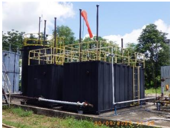
รูปที่ 2-12 คันคอนกรีตล้อมรอบถังเก็บน้ำมันดิบและน้ำ จากกระบวนการผลิต
